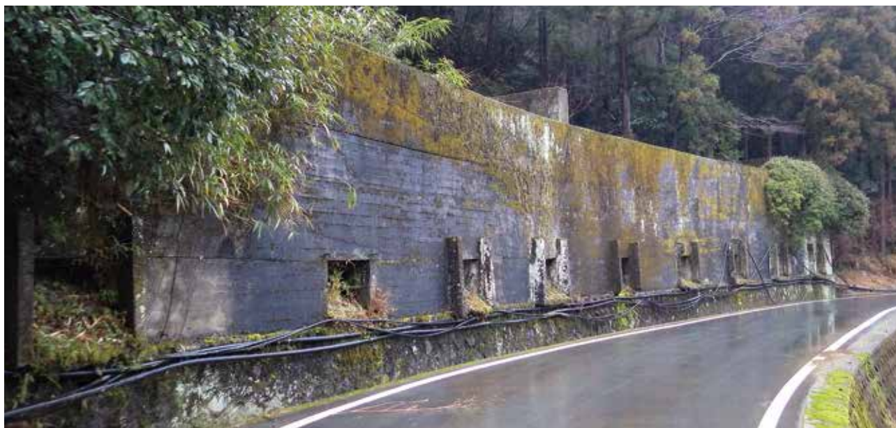
志古の炭鉱施設跡（新宮市）
