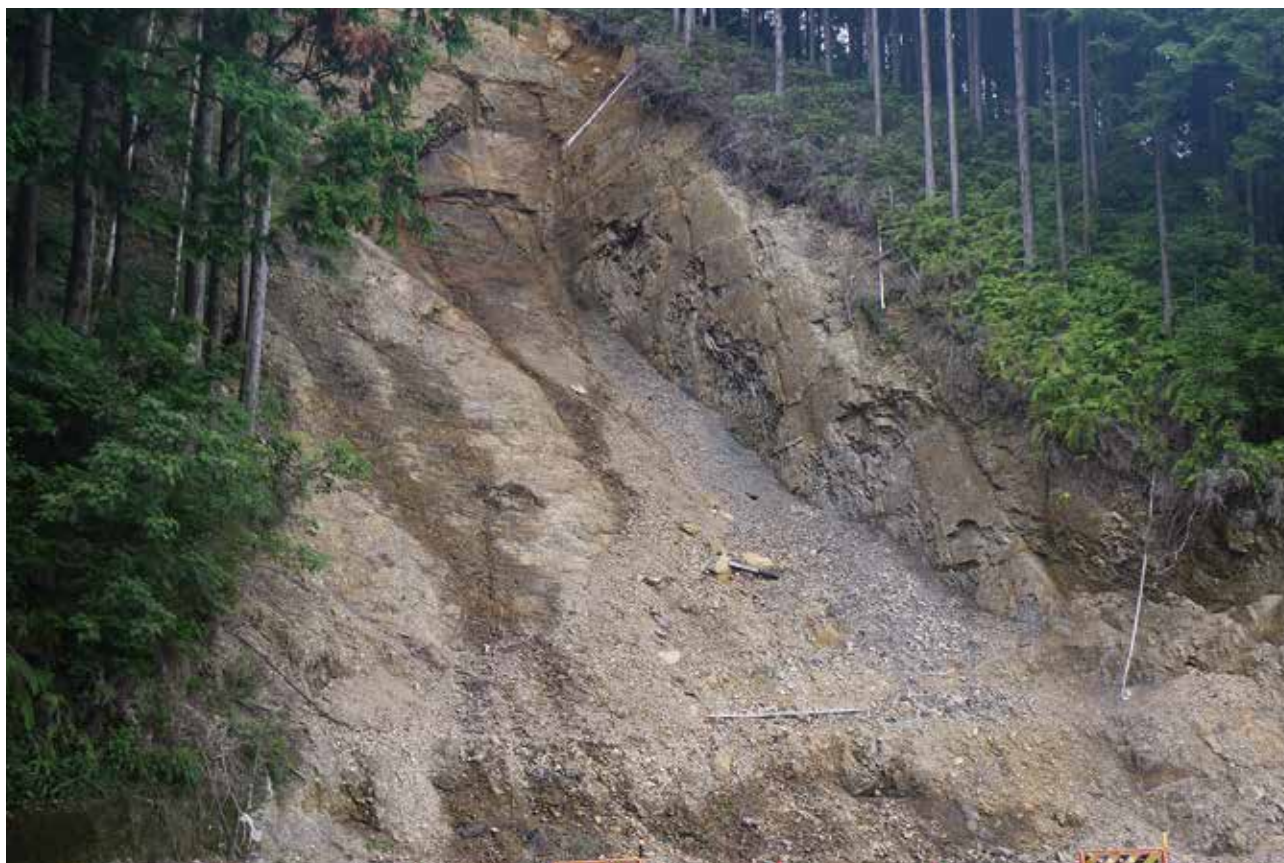
熊野層群の崩壊地（那智勝浦町色川） 2012年8月18日撮影 （和歌山大学災害科学教育研究センター提供）
